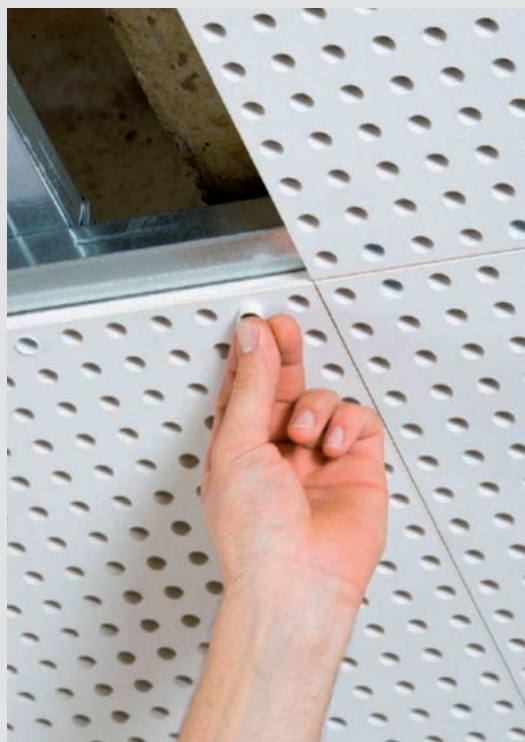
1 Il manicotto di metallo Cleaneo®-Cap viene inserito nel foro.
