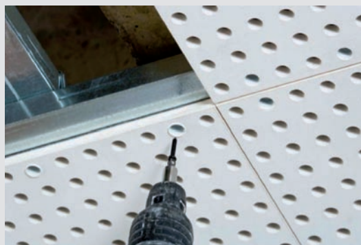
2 A questo punto si inserisce e si fissa la vite. Il grande vantaggio: l'operazione di stuccatura non è più necessaria.
