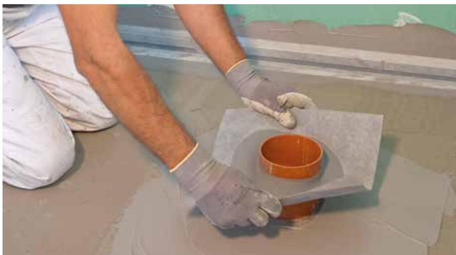
Si stende il secondo strato di impermeabilizzante sull'intera superficie, facendo attenzione ad assicurare lo spessore minimo richiesto dalle norme. A tale fine si consiglia di inserire una rete di armatura.
