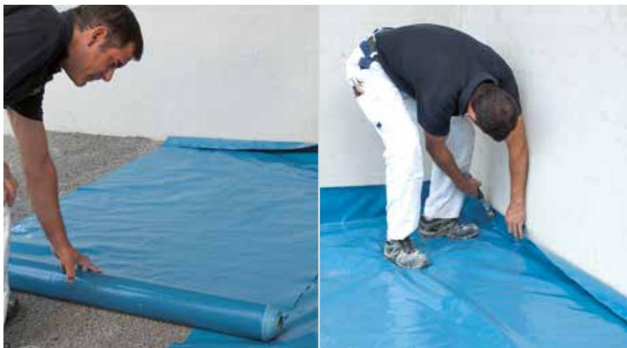
Gli elementi costruttivi verticali vanno separati dal massetto con idonee strisce isolanti di bordo (spessore minimo 10 mm). Quindi si posa lo strato di isolamento in rulli di sistema o in pannelli, incollandolo in corrispondenza dei raccordi.
