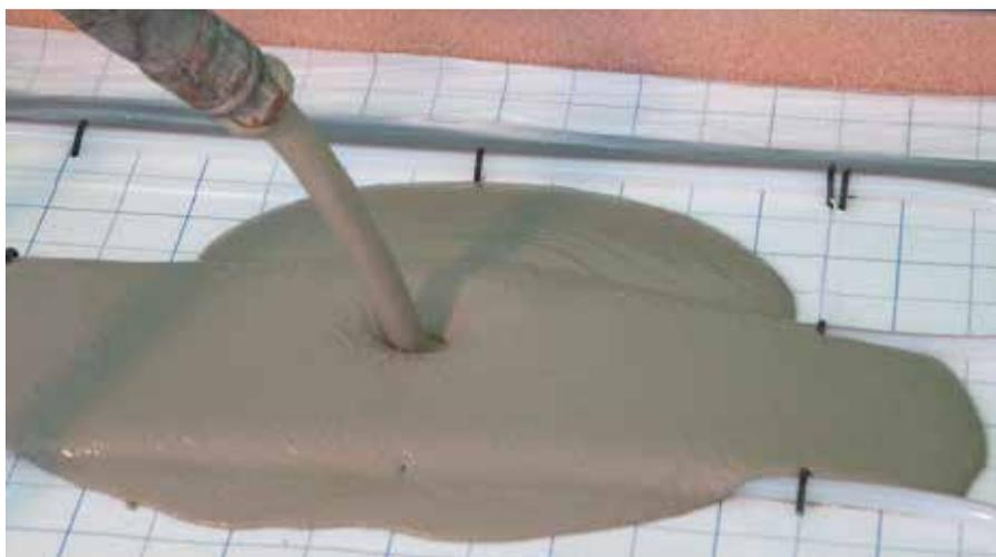
Dopo aver gettato il massetto fino al livello voluto, esso va passato con una staggia livellatrice. La livellatura va effettuata sempre in modo incrociato. Le modalità di lavorazione devono essere tali da permettere di completare la posa entro il tempo massimo di ca. 30–40 minuti.
