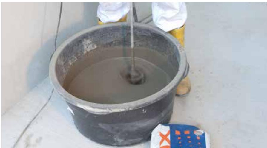
All'inizio del lavoro si regola la consistenza giusta impiegando l'apposita apparecchiatura RÖFIX per la misura del grado di spandimento.
