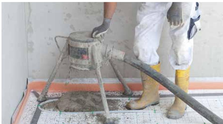
Nel luogo di posa vanno predisposti dei campi in cui il massetto va steso e lisciato con l'apposita assicella corrispondentemente al livello prestabilito. I campi devono riprendere i giunti strutturali esistenti. Le superfici di dimensioni superiori a ca. 40 m<sup>2</sup> vanno suddivise con giunti parziali in campi aventi il lato più lungo non superiore a ca. 8 m. In caso di superfici rettangolari deve essere rispettato un rapporto massimo tra i lati di 1:2,5.
