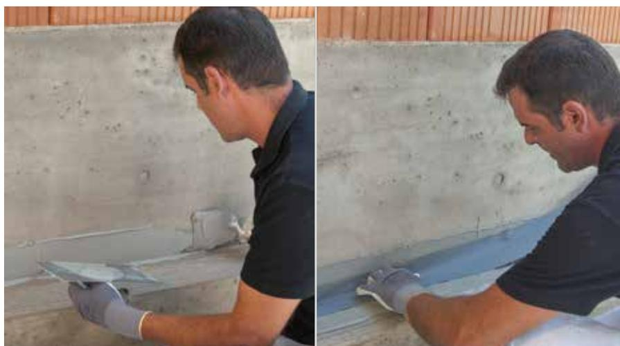
La rasatura impermeabile va applicata sull'intera superficie di supporto in 2-3 mani coprenti con una cazzuola o una pennellessa (consistenza semiliquida).
