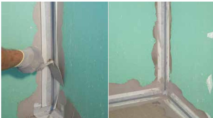
La mascherina isolante va inserita a pressione nella massa dell'impermeabilizzante ancora fresco, ricoprendolo con la stessa.
