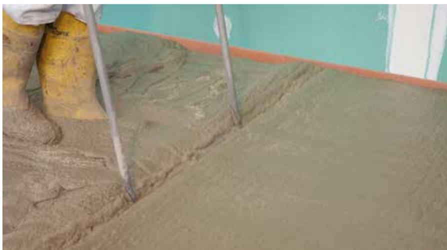
Prima di procedere all'applicazione del rivestimento successivo bisogna misurare l'umidità residua dello strato di compensazione.
