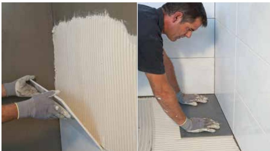
Su pavimenti soggetti ad elevate sollecitazioni meccaniche, a umidità permanente o situati all'esterno, dove quindi sono richiesti requisiti di resistenza al gelo, vanno impiegati rivestimenti in ceramica o in pietra naturale con sistema di posa combinato buttering-floating, facendo attenzione a non lasciare spazi vuoti. La malta adesiva va applicata sia sul supporto che sulla parte inferiore della piastrella.
