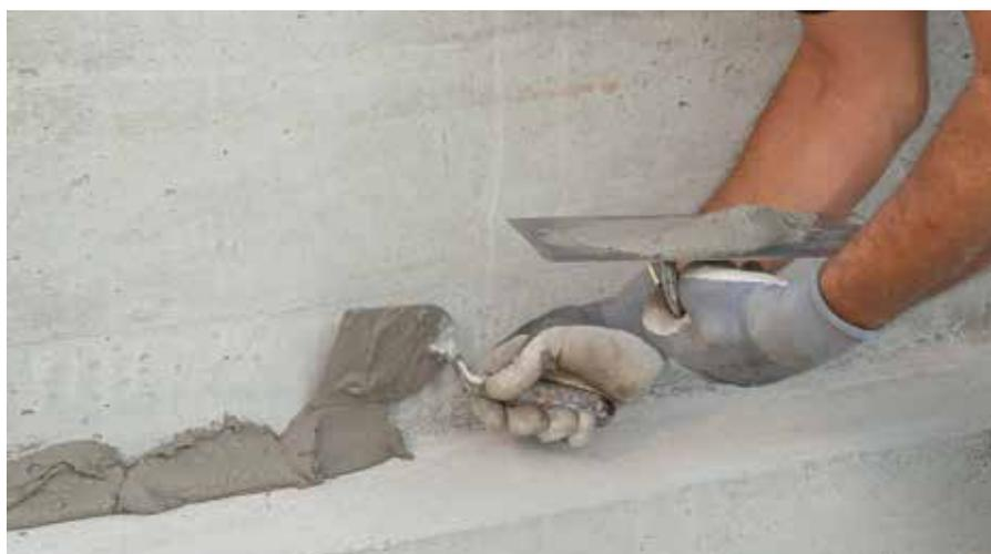
La malta del guscio di raccordo deve essere lasciata asciugare per almeno 24 ore prima di applicare l'impermeabilizzante.
