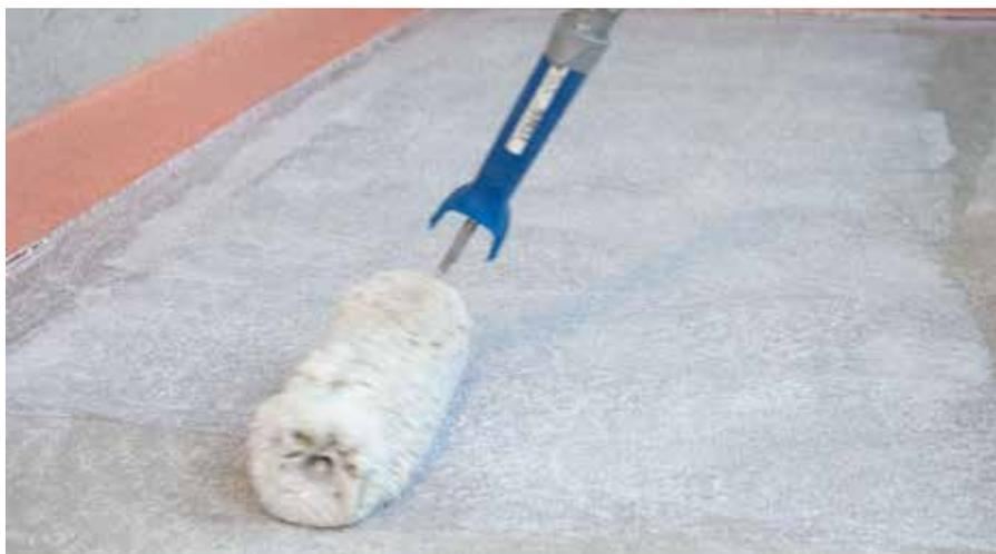
Tutti gli elementi costruttivi verticali vanno separati fisicamente dal pavimento con idonee strisce isolanti di bordo. I singoli campi non devono superare una dimensione massima di 6x6 m o di 36 m<sup>2</sup>.
