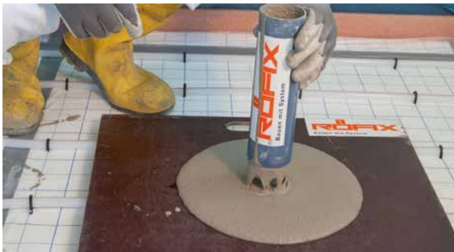
Durante la posa del massetto la bocca del tubo di getto deve essere mantenuta a ca. 10–20 cm sopra il pavimento.
