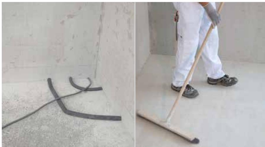
Applicare il materiale di compensazione in conformità al livello di riferimento tracciato sulle pareti.
