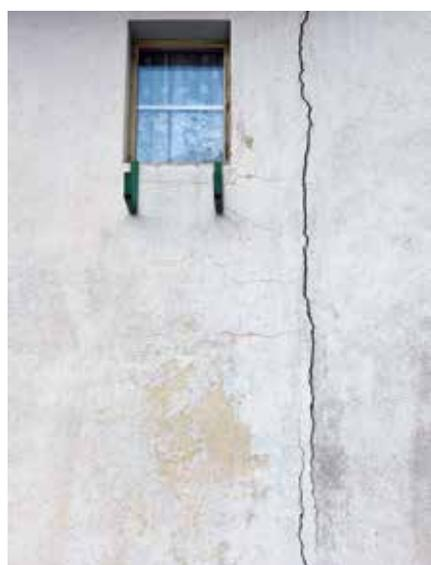
Le facciate sporche sono un ideale terreno di coltura per i **microorganismi**. A tale riguardo, anche la struttura dell'edificio (ad esempio l'insufficiente aggetto del tetto), l'ubicazione e l'ambiente circostante dell'immobile influiscono sull'eventuale crescita di alghe e funghi. Se le facciate sono intaccate da alghe e funghi, è necessario adottare idonei provvedimenti per eliminarli e impedirne la ricrescita.
