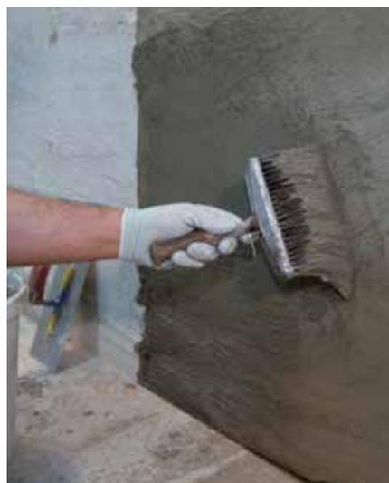
**RÖFIX 636 Malta osmotica impermeabilizzante** è una massa minerale impermeabilizzante per l'impermeabilizzazione di serbatoi, piscine, elementi costruttivi interrati, impianti di depurazione, tubazioni, canali di riscaldamento (min. B225/B25 fino a 5 m di colonna d'acqua).
