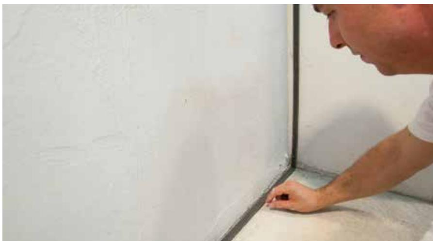
Montaggio di RÖFIX Nastro di guarnizione a giunzioni di parete e soffitto
