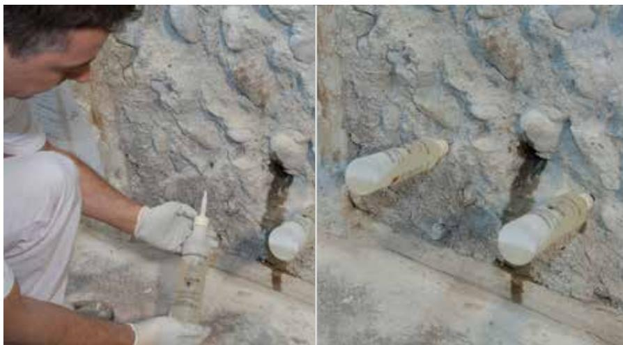
Iniettare RÖFIX Cavastop 10–15 cm superiore del pavimento
