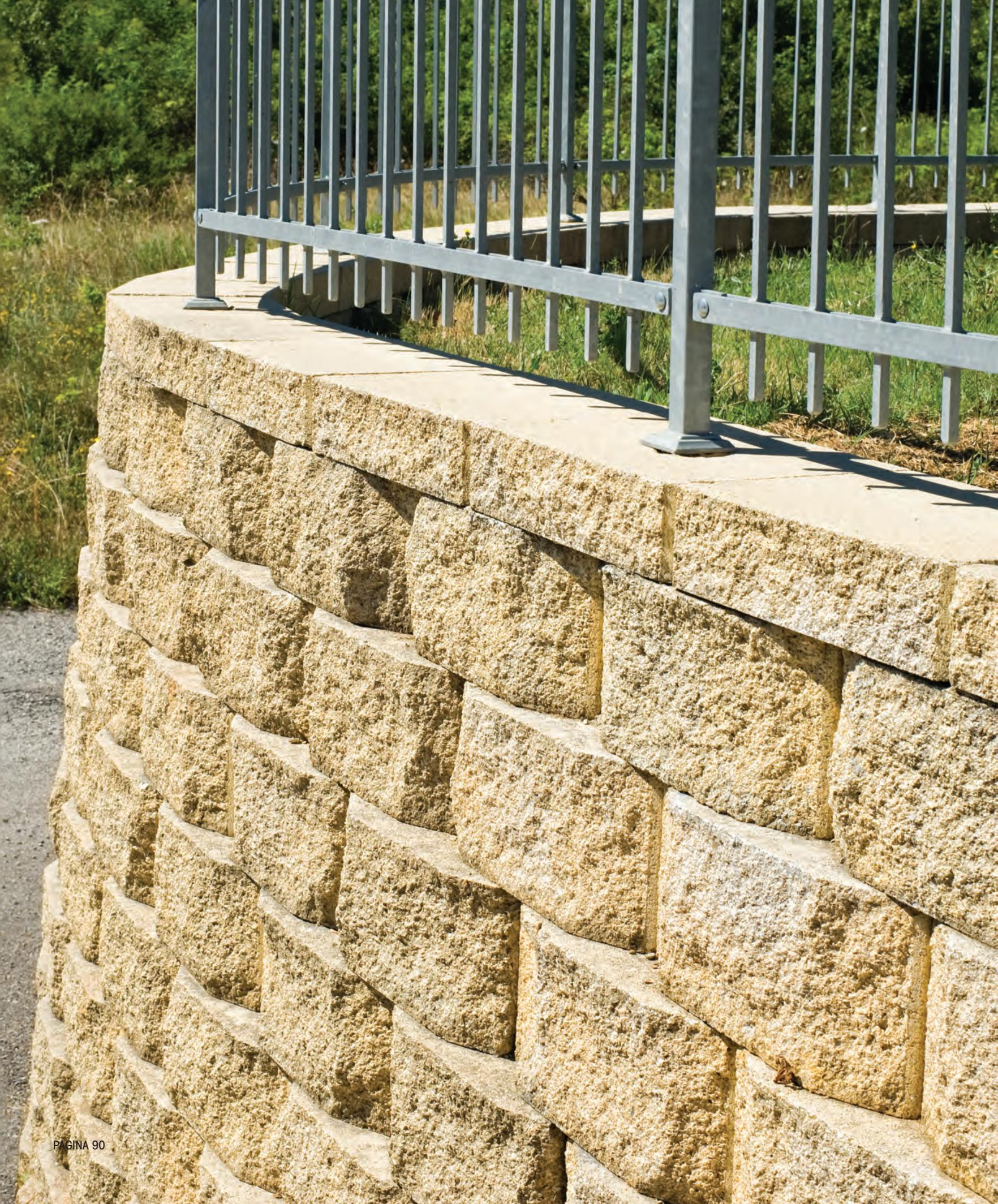
Per chiudere il muro degradando verso il basso, utilizzare metà blocco e le copertine. Il mezzo blocco si ottiene tagliando il blocco dopo aver rimosso la barra di ancoraggio e il distanziale;
