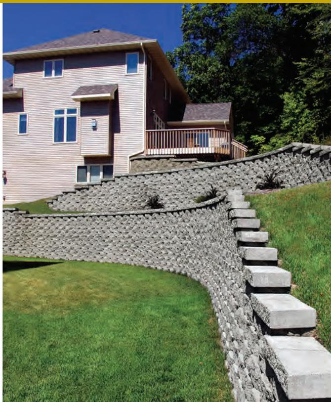
Grazie alla particolare conformazione del blocco si possono creare muri a serpentina con curve concave e convesse di qualsiasi raggio.
