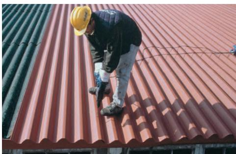
**3. Fissaggio della lastra Fibrall** sulla vecchia copertura con viti Alublok senza rimuovere il vecchio fissaggio.
