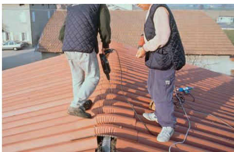
**4. Congiungimento delle falde** tramite colmo di vertice curvo.
