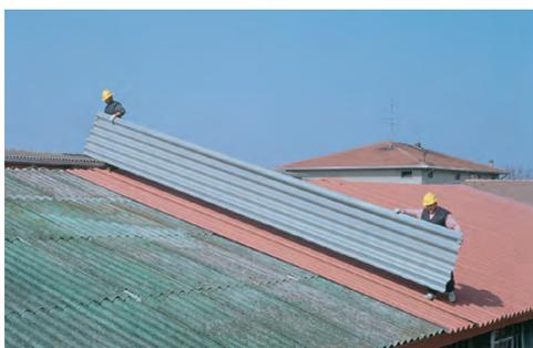
**2. Posa della lastra Fibrall sul vecchio manto.** Le operazioni di posa si effettuano camminando sulle nuove lastre con notevole aumento della sicurezza del cantiere.
