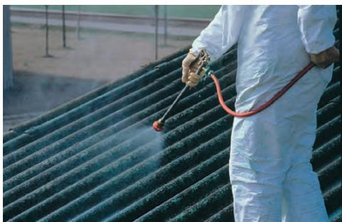
**1. Stesura del fissante Ecofix** per evitare la dispersione di fibre di cemento amianto.
