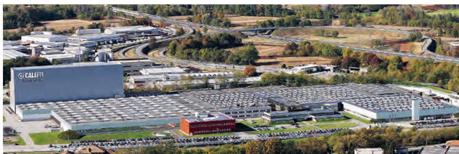
Caleffi S.p.A. - Sede centrale - Stabilimento 1 Fontaneto d'Agogna - ITALIA
