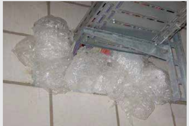
Chiusura con materiale non idoneo (nylon)
