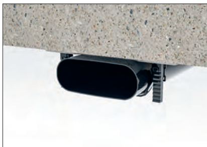
Canale piatto su solaio cantina
