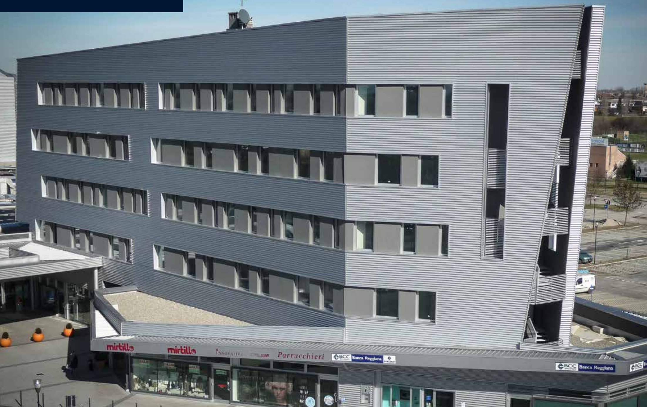
CENTRO COMMERCIALE BAGNOLO IN PIANO (RE) Ond-All 33
