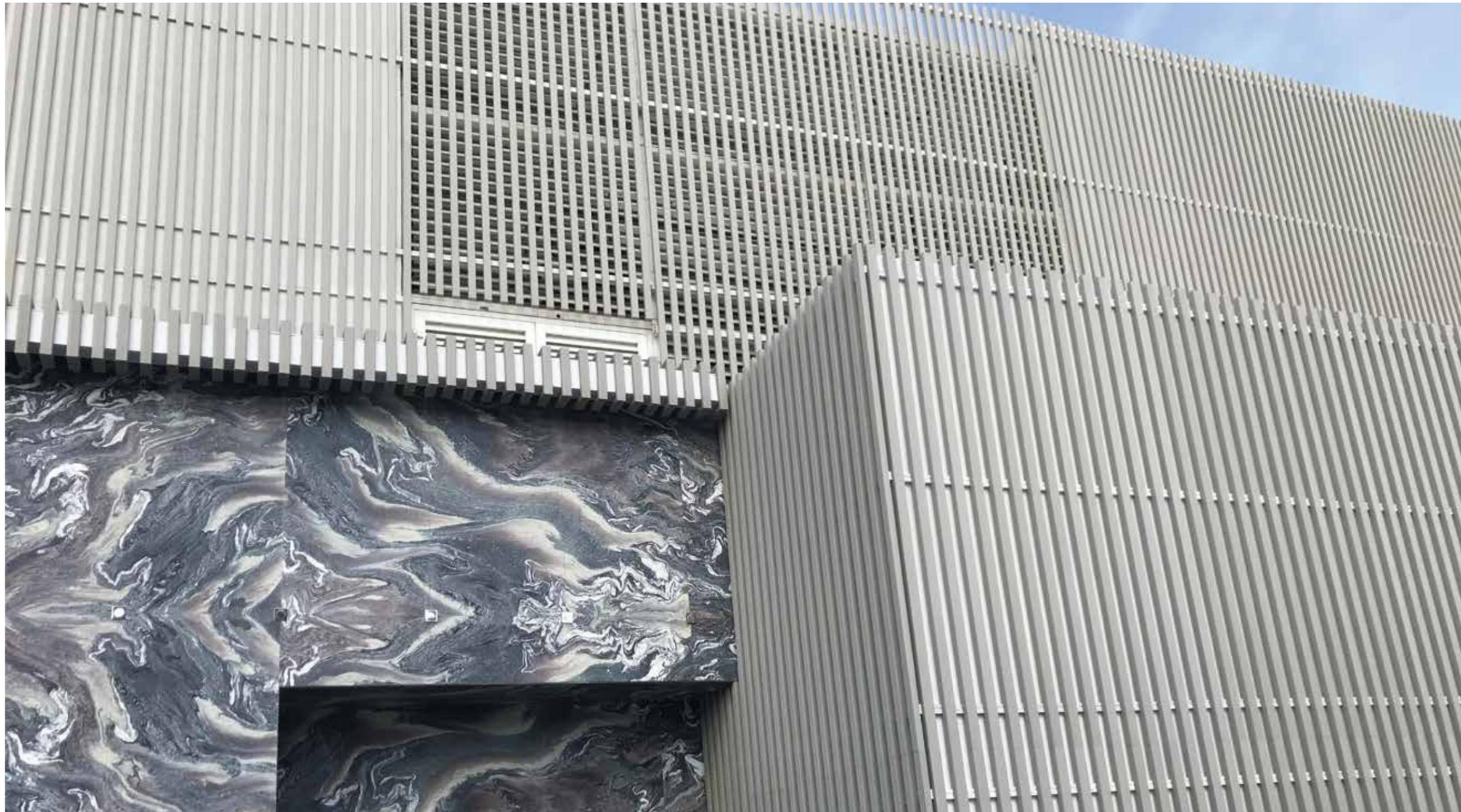
I rivestimenti di facciata vengono realizzati con le doghe o con i profili architettonici Tecnodeck®. La scelta del prodotto va effettuata nell'ambito dello specifico progetto.
