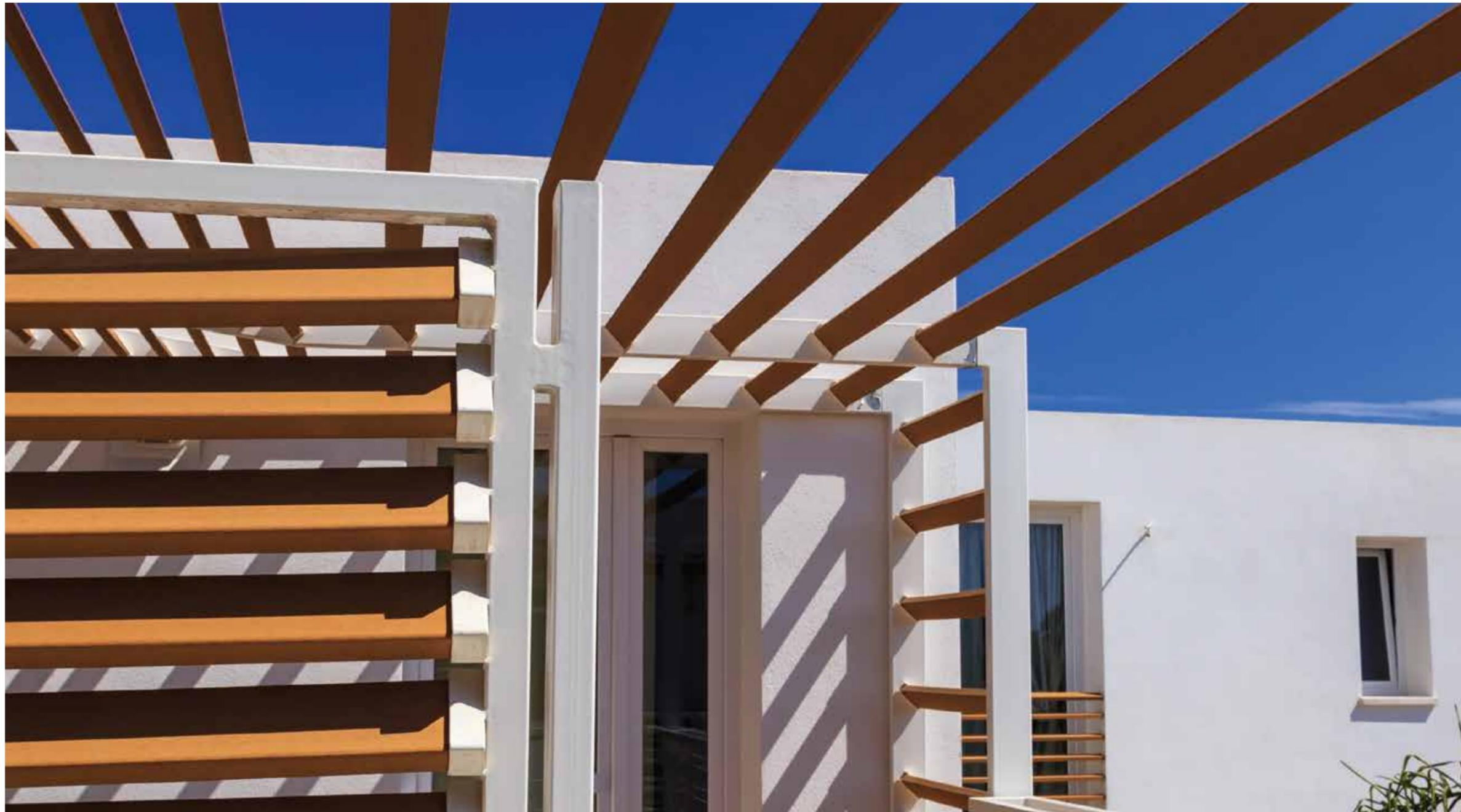
Coordinabili con le doghe per pavimentazione, di cui offrono le stesse caratteristiche di resistenza, i profili architettonici Tecnodeck® abbinano un esterno in WPC ad un'anima strutturale in alluminio.
