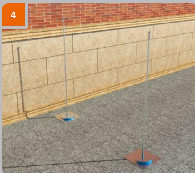
С помощью анкерных болтов прочно зафиксировать фланцы на поверхности.
