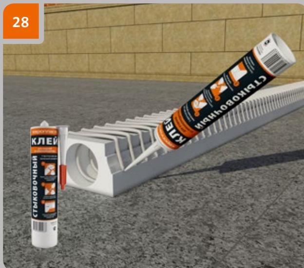
Заполнить разрезы клеем «Европласт Стыковочный» с избытком.
