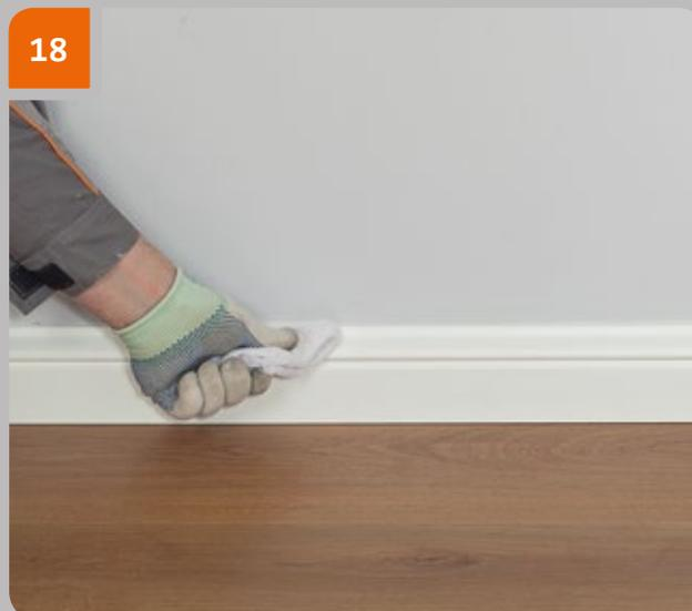
Удалить излишки клея тканью, смоченной водой — при использовании клея «Европласт Монтажный», ацетоном — при использовании клея «Европласт Универсальный».
