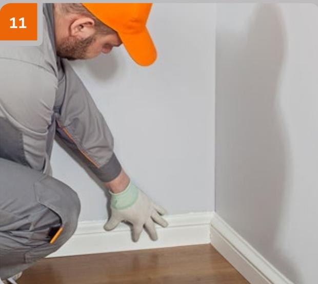
Прижать изделие к стене и полу, чтобы клей выступил из-под всей плоскости примыкания к стене. Смещая изделие вдоль стены, прижать к соседнему изделию, чтобы клей выступил на стыке.
