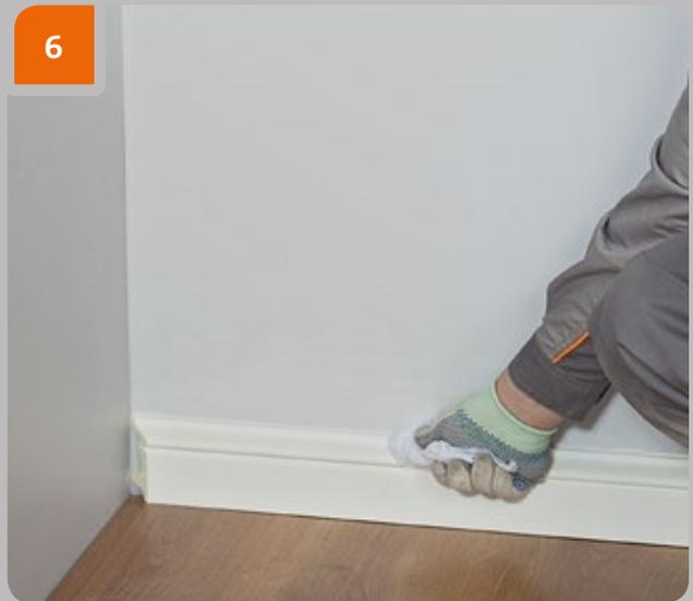
При необходимости места примыкания изделия к стене протереть тканью, смоченной водой — при использовании клея «Европласт Монтажный», ацетоном — при использовании клея «Европласт Универсальный».
