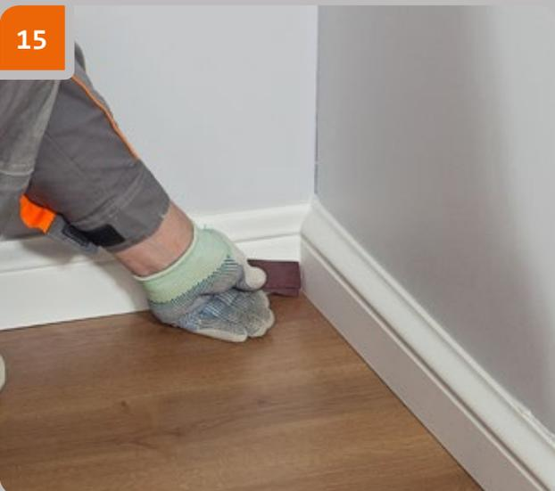
Спустя 3 часа мелкозернистой наждачной бумагой обработать стыки.
