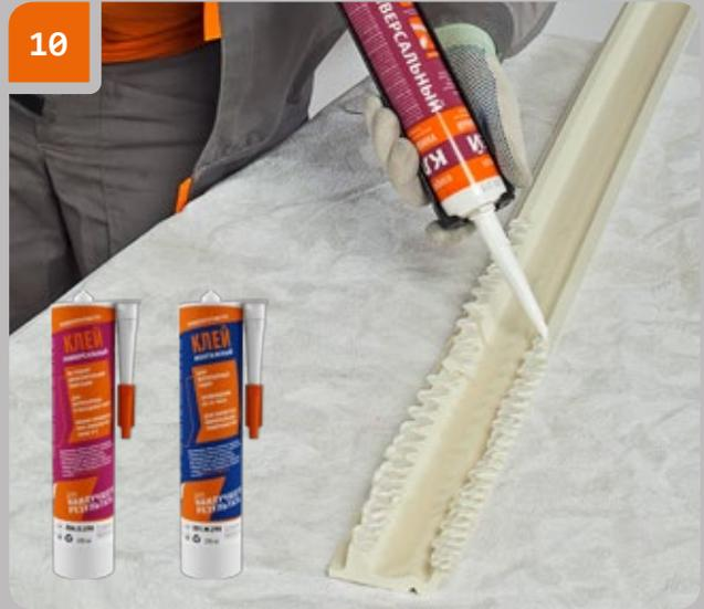
Нанести клей «Европласт Монтажный» или «Европласт Универсальный» на монтажную поверхность (только на места примыкания к стене) следующего изделия.
